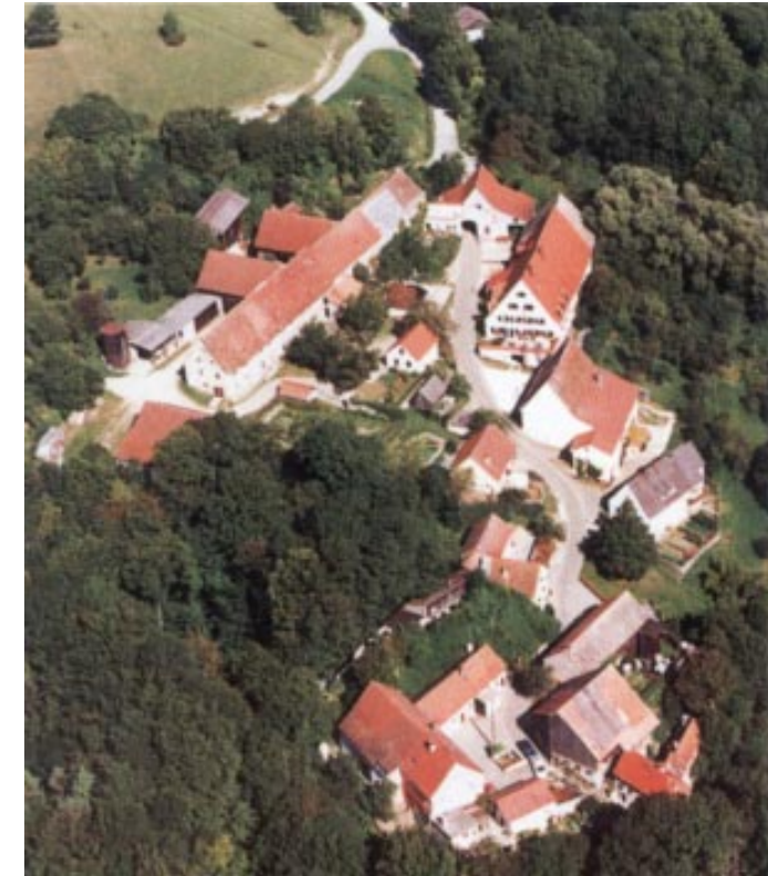
Burg Hofberg mit Vorbürg (oben) und Hauptburg
