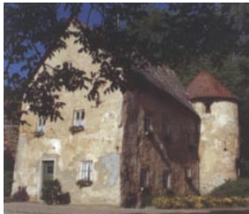
Das einstige Torwärterhaus mit einem Turm der Ringmauer
